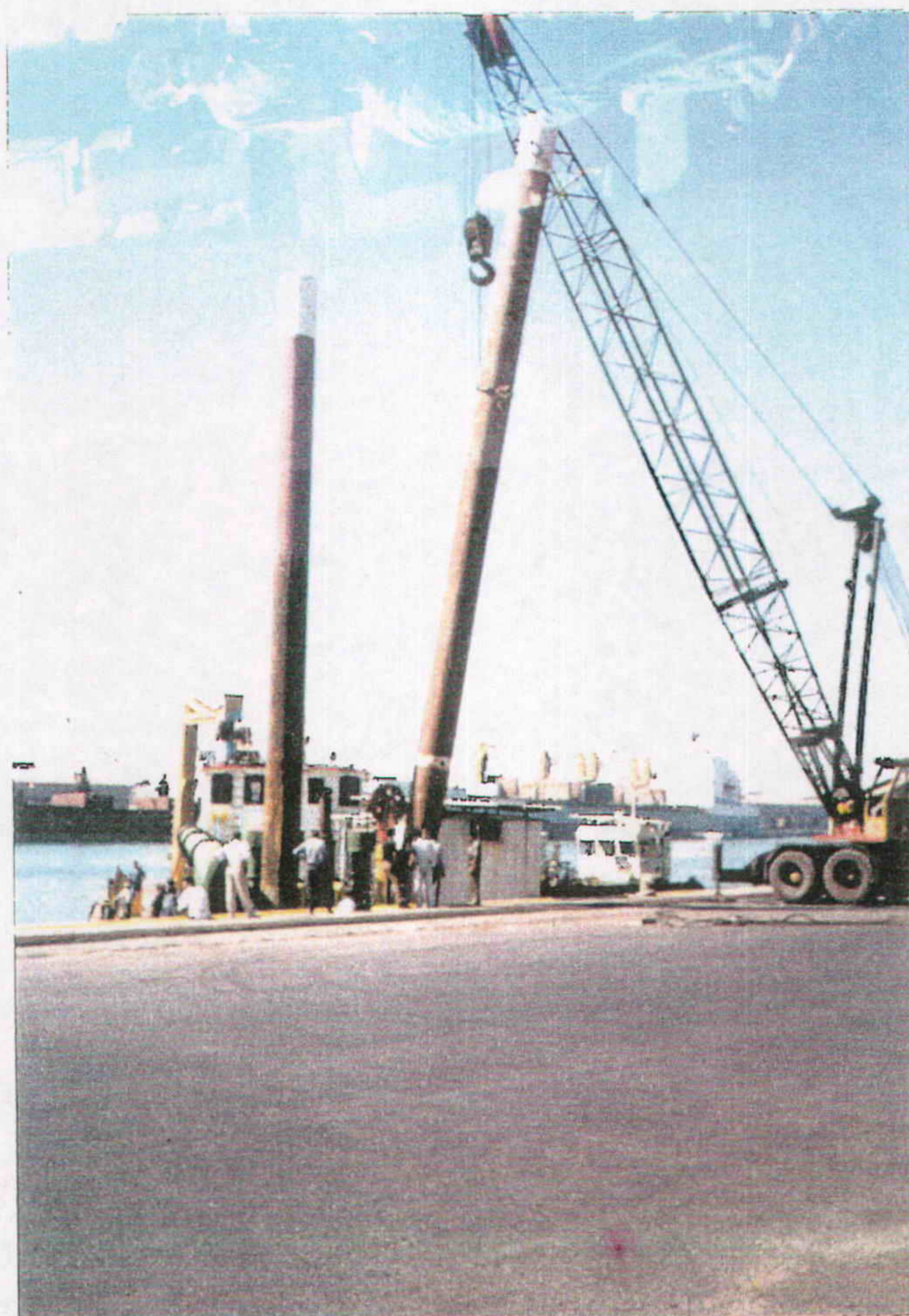
شکل ۲۹-۳ عملیات نصب اسپادها روی لایروب پارسا (بندر شهید رجایی)
