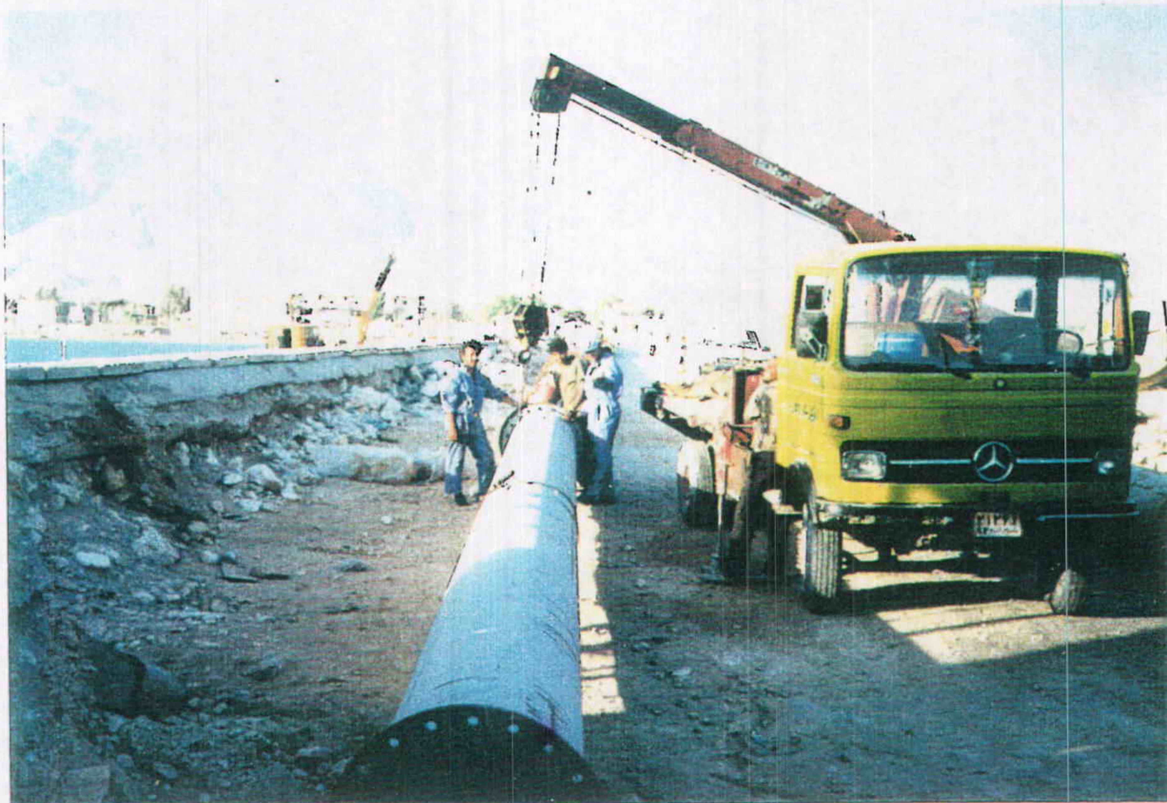
عکس ۲-۲ عملیات ساحلی - تجهیز کارگاه یک پروژه کاتر ساکشن
