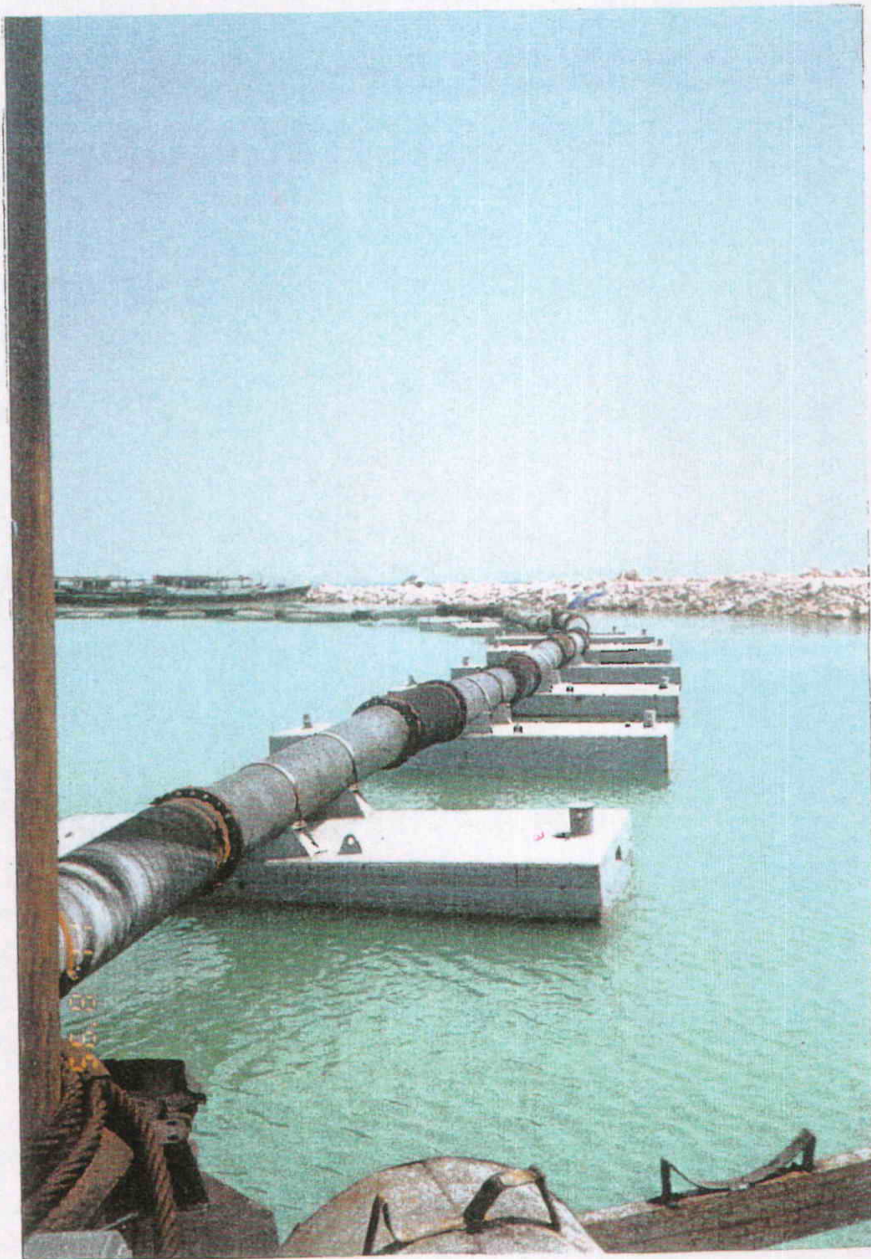
شکل ۳-۳۲ خط شناور با پانتون های مکعبی
