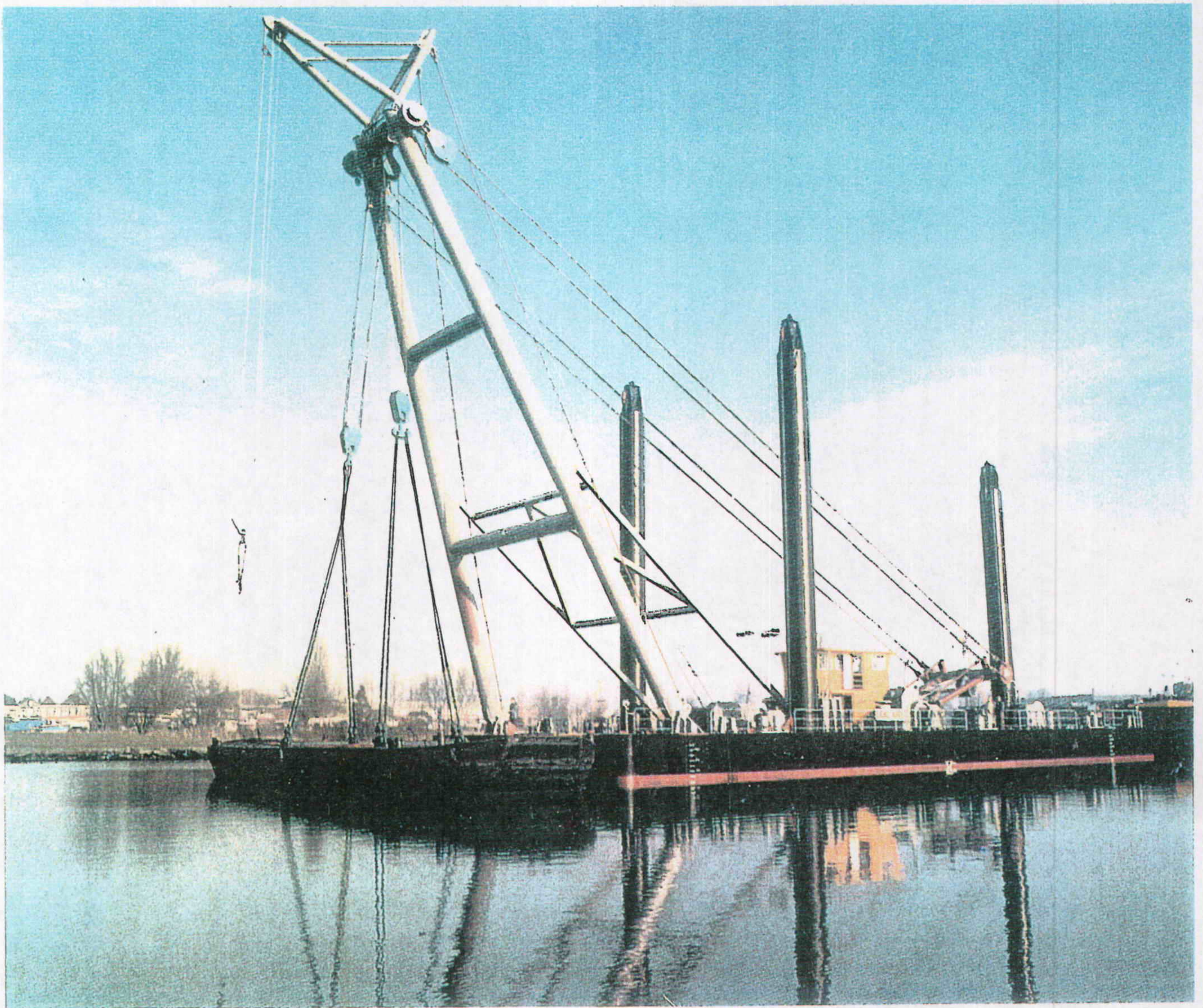
شکل ۱۰-۳- لایروب Float Crane مشغول عملیات لایروبی
