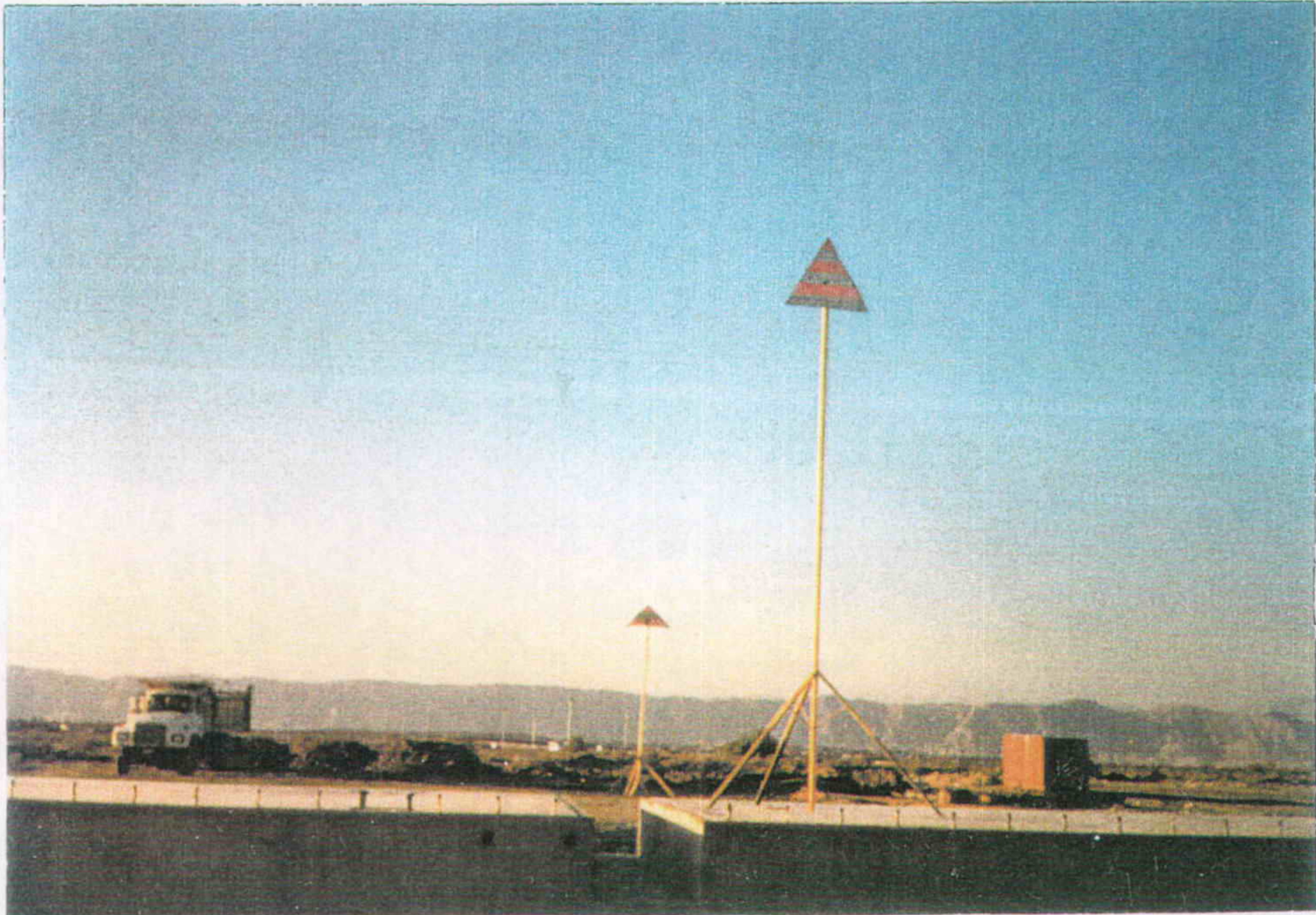
شکل ۱۰-۲ شاخص های محور کانال Channel Transites
