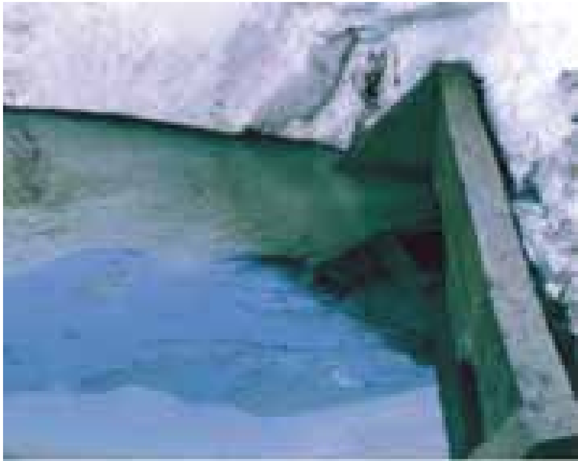
عکس 20: نفت بانکر C، با میزان دانسیته و ویسکوزیته بالا که در فاضلاب ریخته شده است
