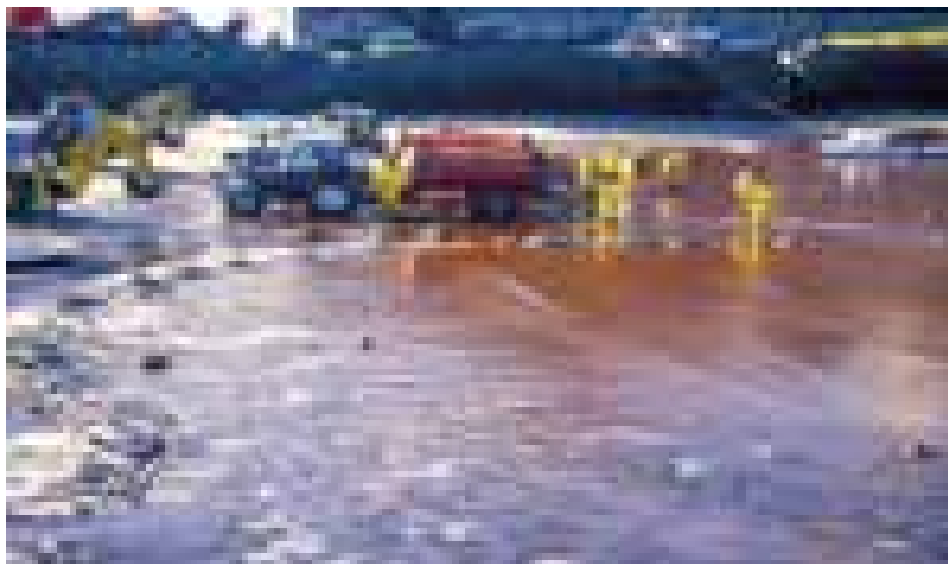
عکس 130: استفاده از سیستم مکش برای جمع‌آوری مواد نفتی از کنار ساحل
